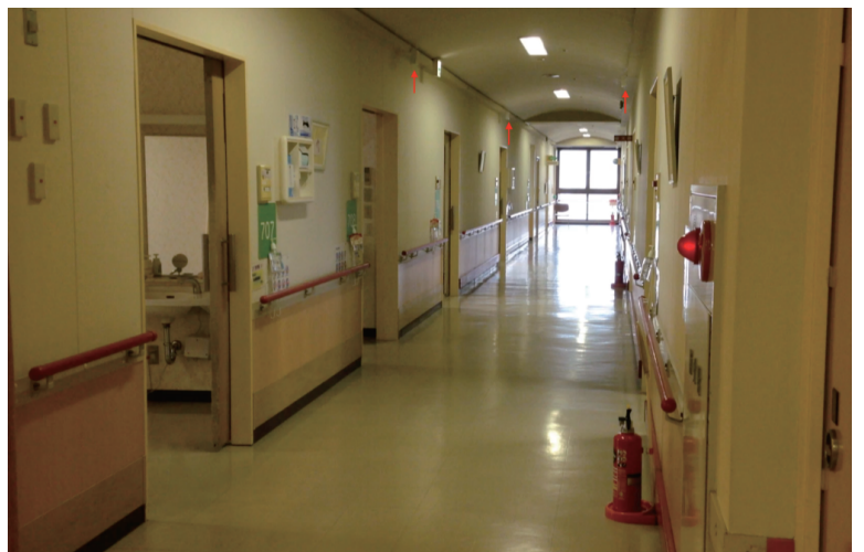
図5 受信機の設置状況
